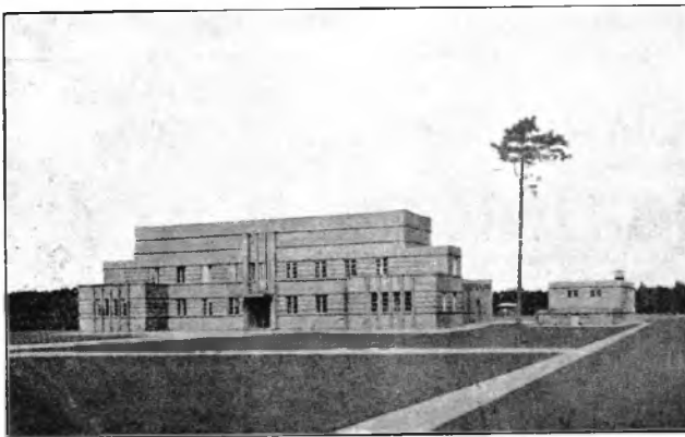
Vooraanzicht van het Stations gebouw, rechts op de foto het huisje waarin de koelinstallatie is ondergebracht.
